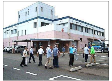
30/6/19 汚泥処理センター
